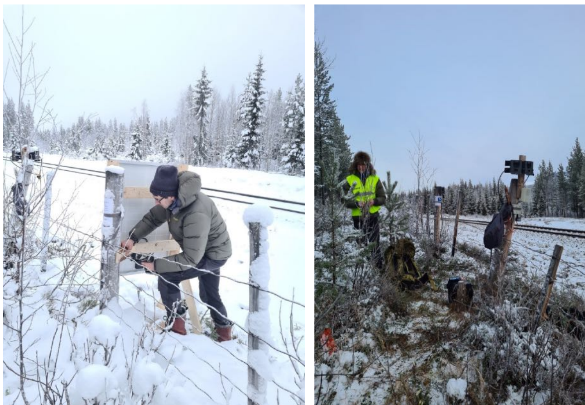
Figur 8. Montering av MASS enheter vid Nordlandsbanen.
